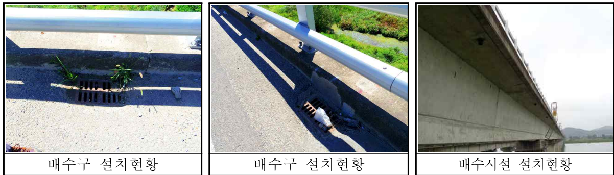
【그림 3.25】 배수시설 현황
