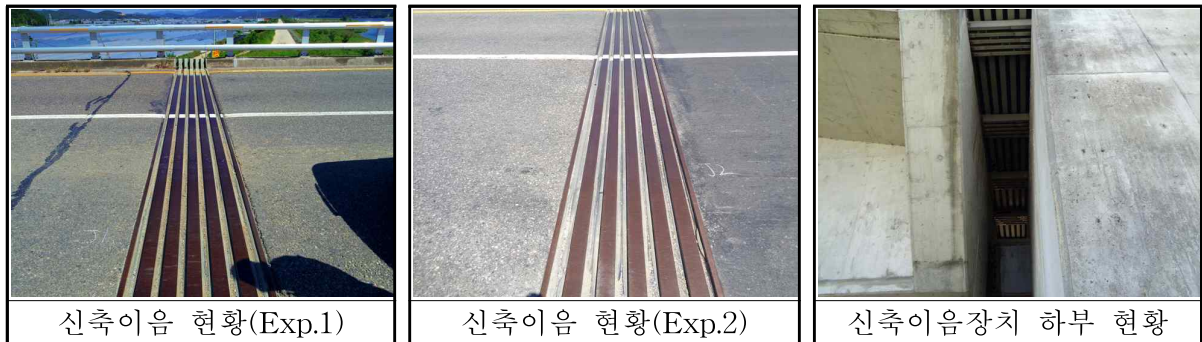
【그림 3.22】 신축이음장치 현황 및 외관조사
