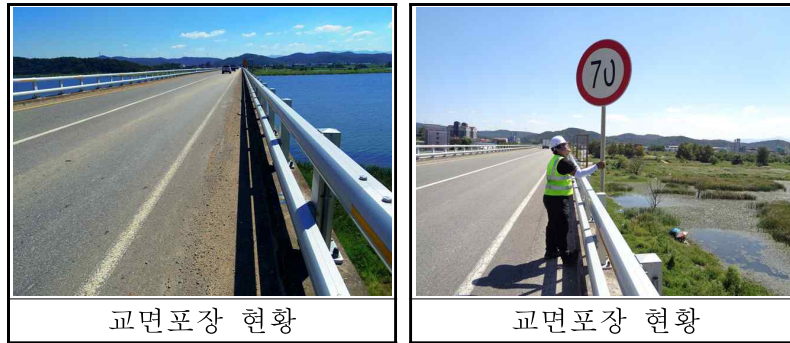
【그림 3.3】 교면포장 현황
