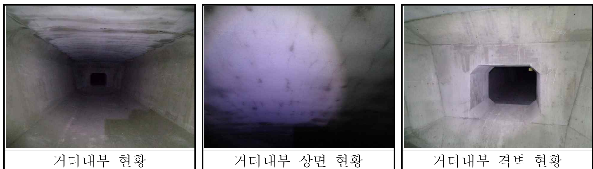
【그림 3.9】 거더 내부 현황
