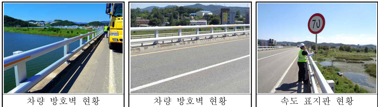
【그림 3.6】 방호벽/중앙분리대 현황
